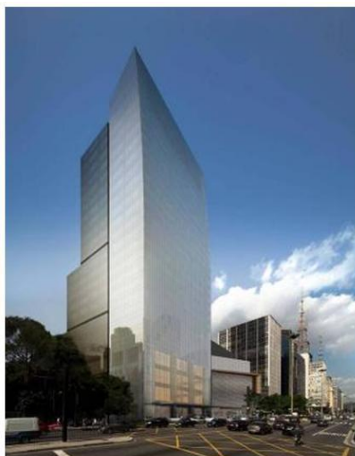
Figura 2: Projeto do escritório Aflalo/Gasperini arquitetos conjuga horizontalidade e verticalidade no conjunto da torre e do shopping. 5
